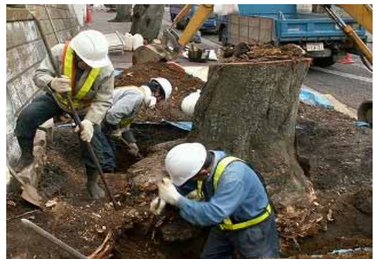
枯れた桜の抜根作業 中央桜通り（C4） 平成19年3月5日
